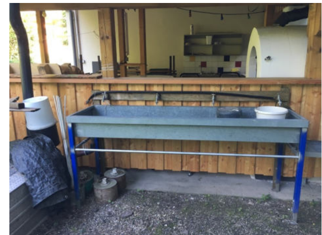
Zusätzliche Abwasch und Ablauf für Abwaschwasser beim Carport
